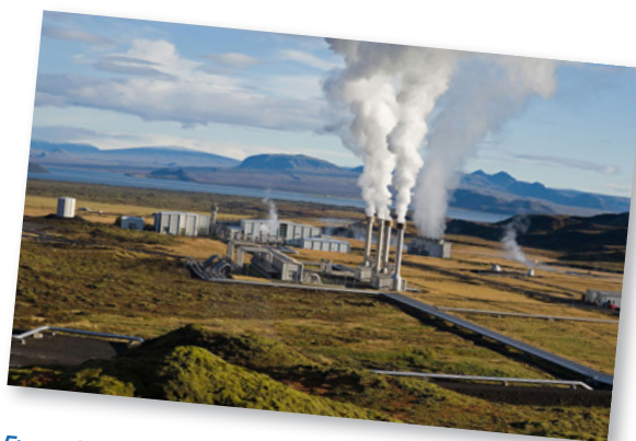
Exemple d'une centrale géothermique. Photo: Centrale géothermique de Nesjavellir en Islande, Gretar Ívarsson, Wikipedia
