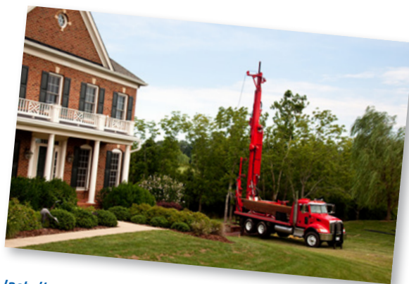
Installation d'une pompe à chaleur. Photo: Installation d'une sonde géothermique, Steve Heap, Shutterstock
